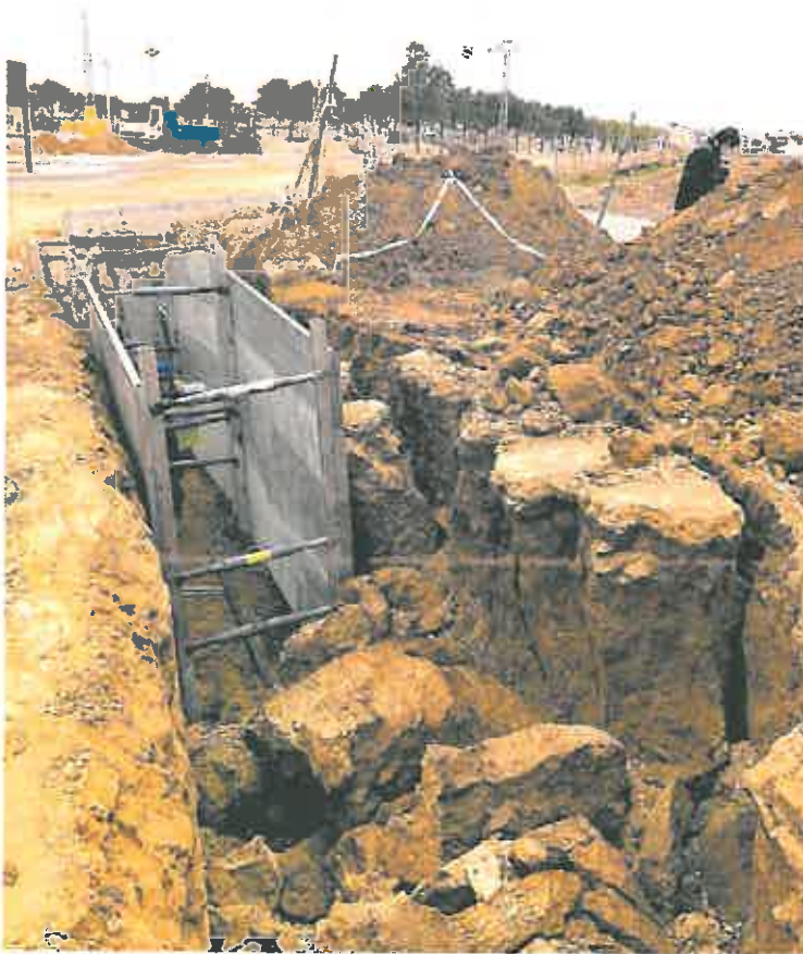
Construcción de un colector de aguas pluviales en Las Alcázaras.
