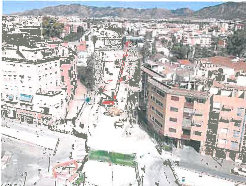
Construcción de las pantallas del soterramiento junto a la estación del Carmen, en dirección a Barriomar.
