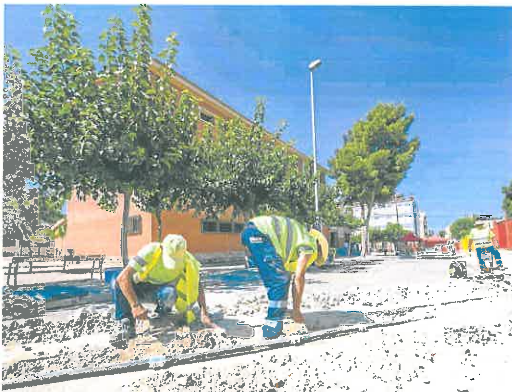
Obras de renovación de la tubería que abastece de agua al colegio Virgen de la Fuensanta de La Alberca. ROS CAVAL / AGF
