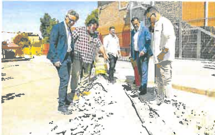
El alcalde, José Antonio Serrano, visita las obras del colegio Nuestra Señora de la Fuensanta.
