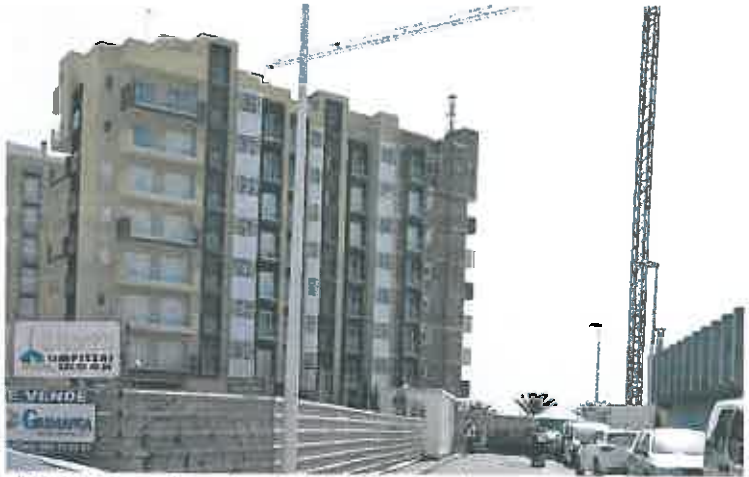
Edificio de La Manga en el que cayó un trabajador desde un quinto piso.
