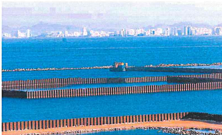
Construcción de Puerto Mayor, en La Manga, en junio de 2005. J. M. RODRÍGUEZ / AGM
