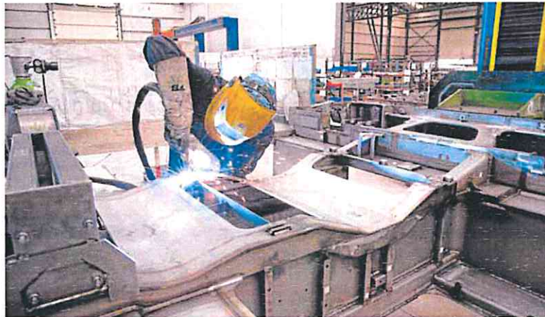
Un trabajador suelda en los talleres de Metalmeccánicas Herjimar, en el polígono Los Camachos. A. GIL / AGH
