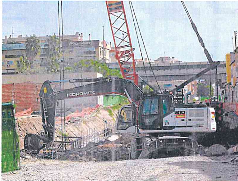
Obras de soterramiento de las vías entre El Carmen y Barriomar, la semana pasada. GUILLERMO CARRIÓN / AGM
