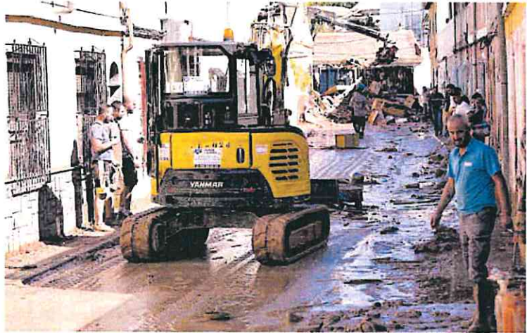
Labores de limpieza en la calle San Nicolás tras la tromba de agua caída en septiembre.
