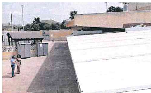
Retirada de amianto en colegios de Cartagena.
