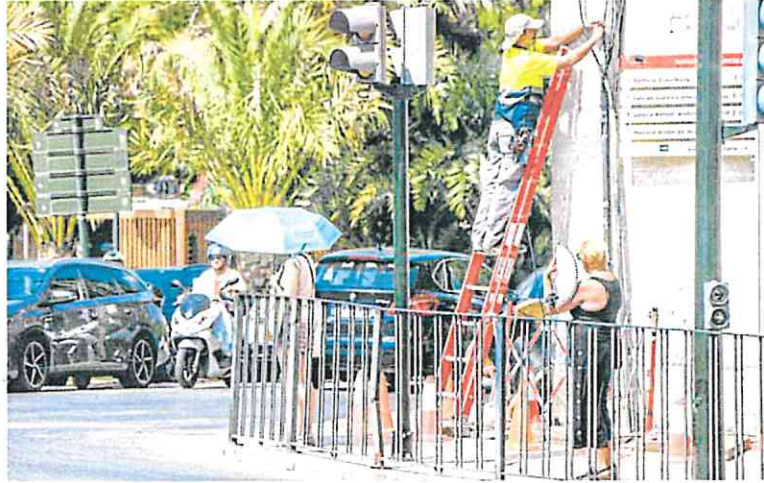
Un trabajador arregla unos cables en el centro de Murcia, en plena ola de calor. ROS CAVAL / AGF
