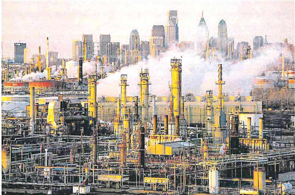
Una refinería de petróleo propiedad de The Carlyle Group, en Filadelfia (EE UU).
