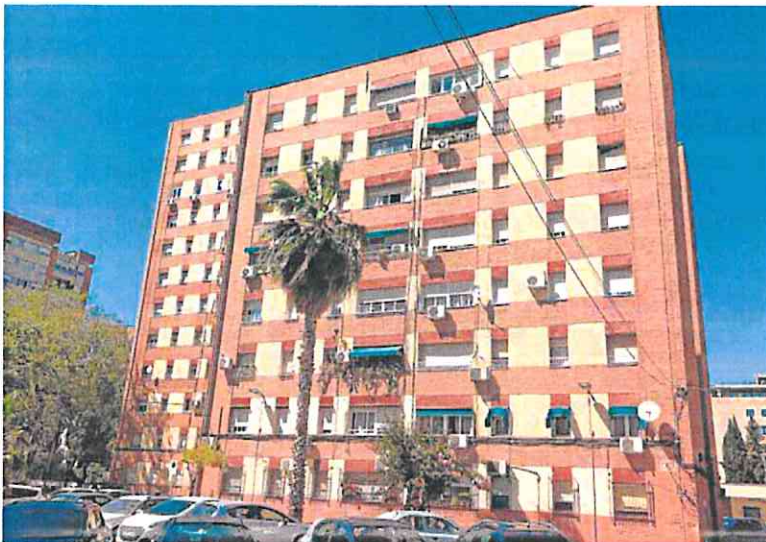
Bloque de viviendas sociales de distintas tipologías en el barrio de La Fama, en Murcia. MARTÍNEZ BUENO
