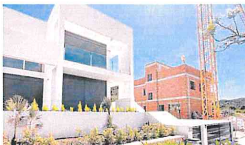
Imagen de uno de los nuevos chalés que se están construyendo. LV
