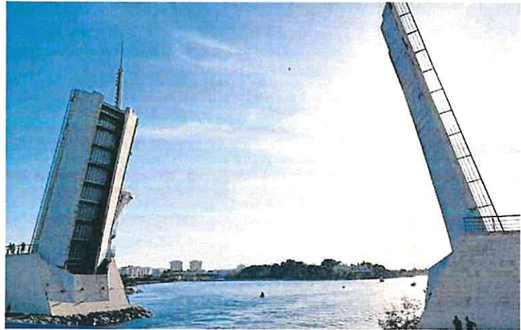
Nueva rotura en el puente del Estacio, el pasado 18 de agosto.
