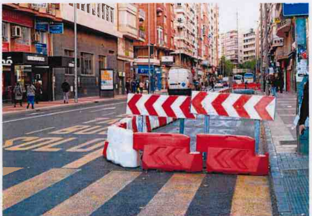
Las obras pospuestas en la céntrica avenida de la Constitución comenzaron este lunes. JAVIER CARRÓN / AGN
