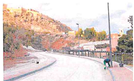
Un operario realiza los remates finales en el vial en San Lázaro. J. I. / AGM
