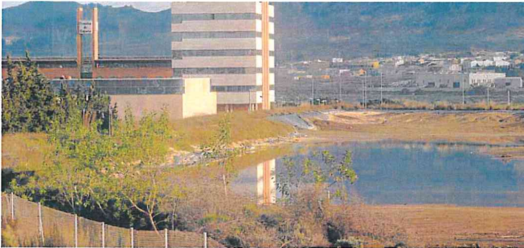
Estado de una de las balsas de residuos peligrosos, junto al polígono Cabezo Beaza, en una imagen tomada en enero. PABLO SÁNCHEZ DEL VALLE / AGH
