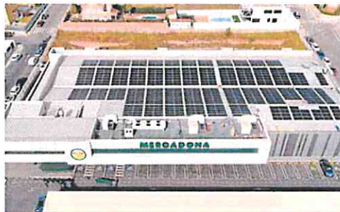
Cubierta con paneles solares de una tienda de Mercadona.
