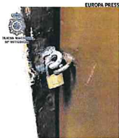
Detalle de la puerta de la habitación.
