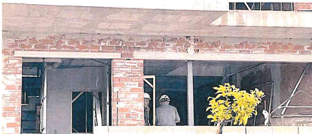
Una vivienda en construcción en el municipio de Murcia.
