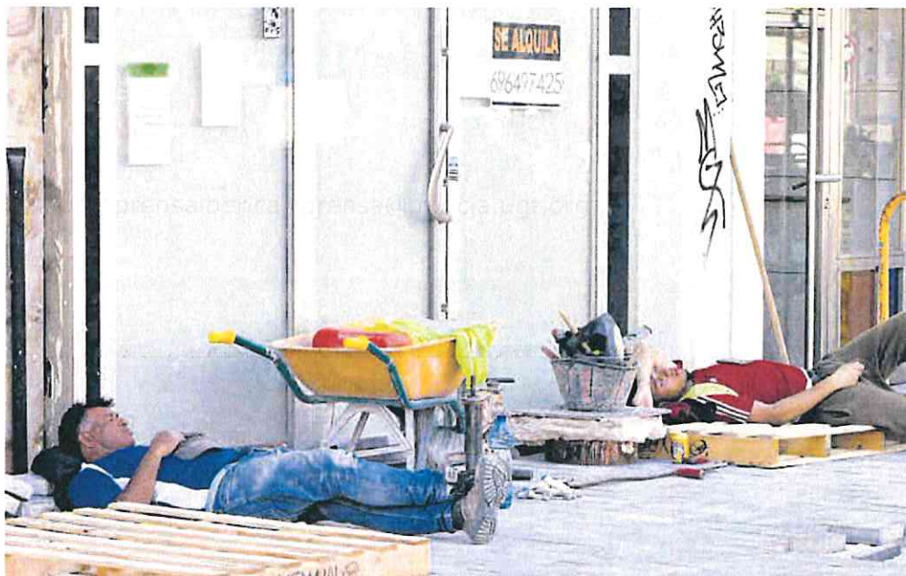
Dos trabajadores de las obras del plan de movilidad de Murcia descansan a la sombra en Ronda Norte.
