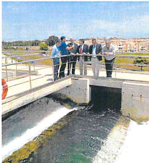
Instalaciones de la desaladora de Torrevieja. NACHO GARCÍA / AGH
