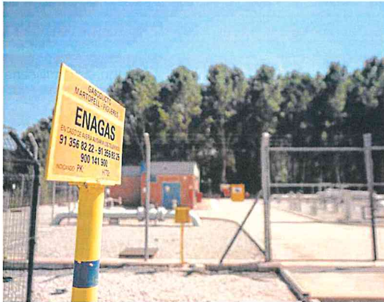
Instalación de gas natural en Barcelona. A. QUIROGA
