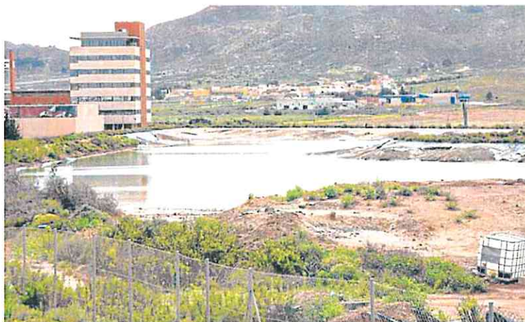
Vista de una de las balsas de residuos peligrosos de Zinsa, en Cartagena, en una foto de archivo. J. M. R.
