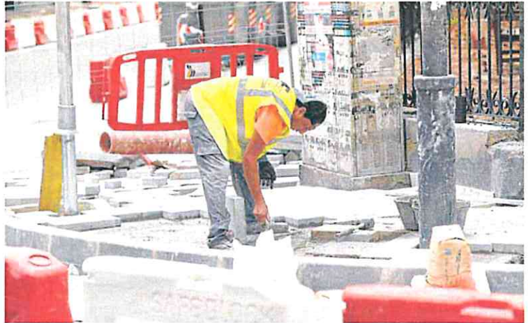
Un joven operario trabaja en las obras de enlosado de una acera, ayer, en Murcia. GUILLERMO CARRIÓN / AGN
