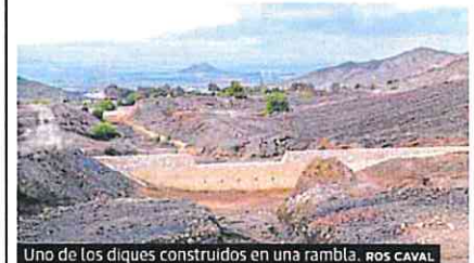
Uno de los diques construidos en una rambla. ROS CAVAL
