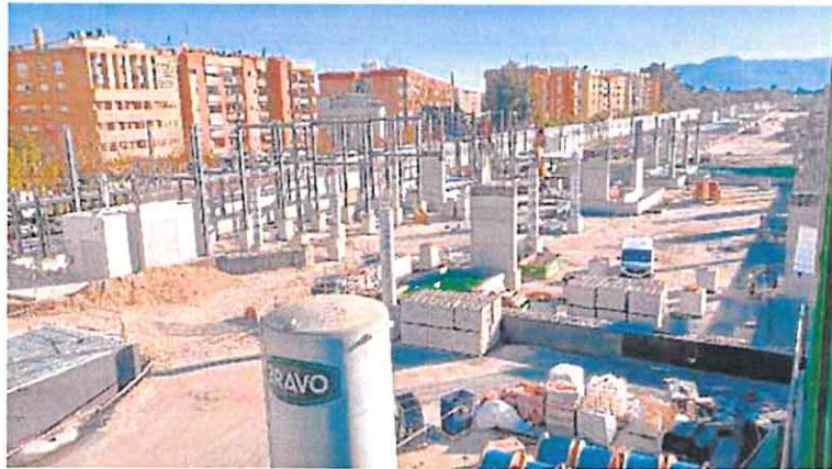
Cimentación y montaje del edificio definitivo de la estación en superficie de 4.400 metros cuadrados. ADIF
