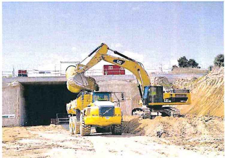
Dos máquinas trabajan junto al túnel del AVE en Alcantarilla.
