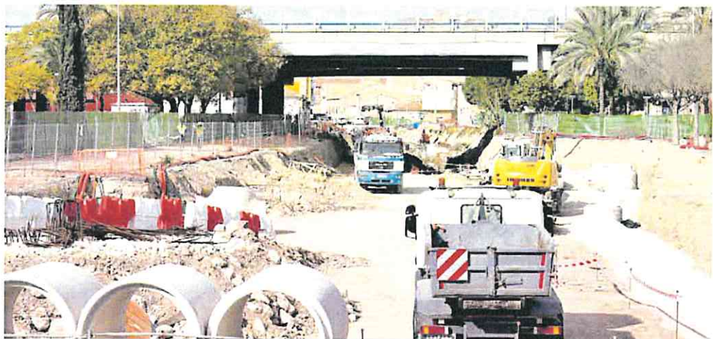
Trabajos de la Alta Velocidad entre El Carmen, Barrilomar y Nonduermas el pasado mes de marzo
