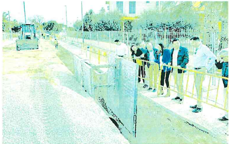
La consejera Sara Rubira visita, junto al alcalde de San Javier, los trabajos de construcción.
