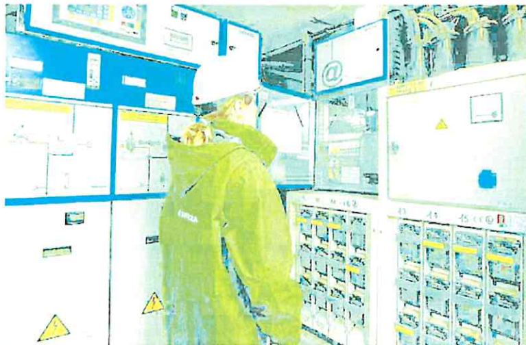
Una operaria de Iberdrola revisa los contadores de electricidad de un edificio de viviendas. iv
