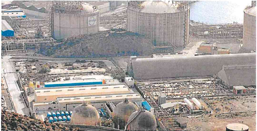
La desaladora de Escombreras, en primer término, junto a las instalaciones de Enagás, en la dársena de Escombreras. ANTONIO GIL / AGN
