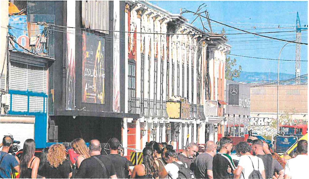
Vecinos y clientes observan las fachadas de las discotecas Teatre y Fonda Milagros, en la zona de Atalayas, afectadas por el fuego. JAVIER CARRIÓN / AGN
