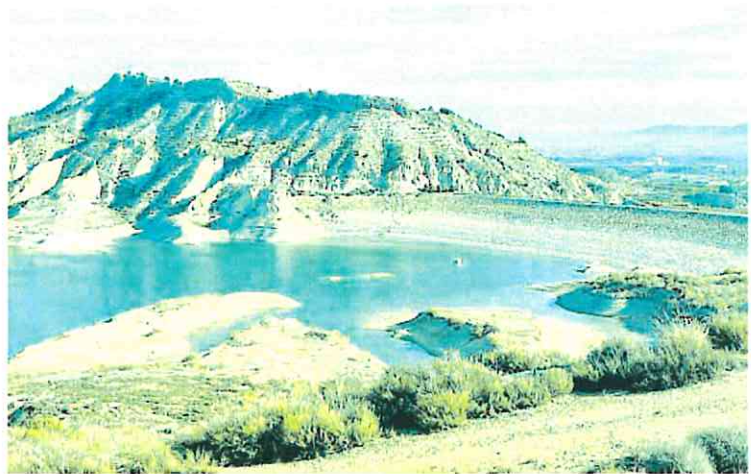
Falta de agua en el embalse de la Rambla de Algeciras, en Alhama de Murcia.
