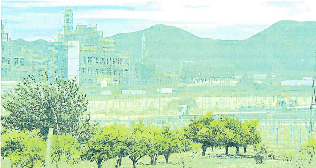
Un grupo de obreros trabaja en la construcción de una planta fotovoltaica de Sabic e Iberdrola, junto a la factoría de producción de plásticos. A. GIL / AGH
