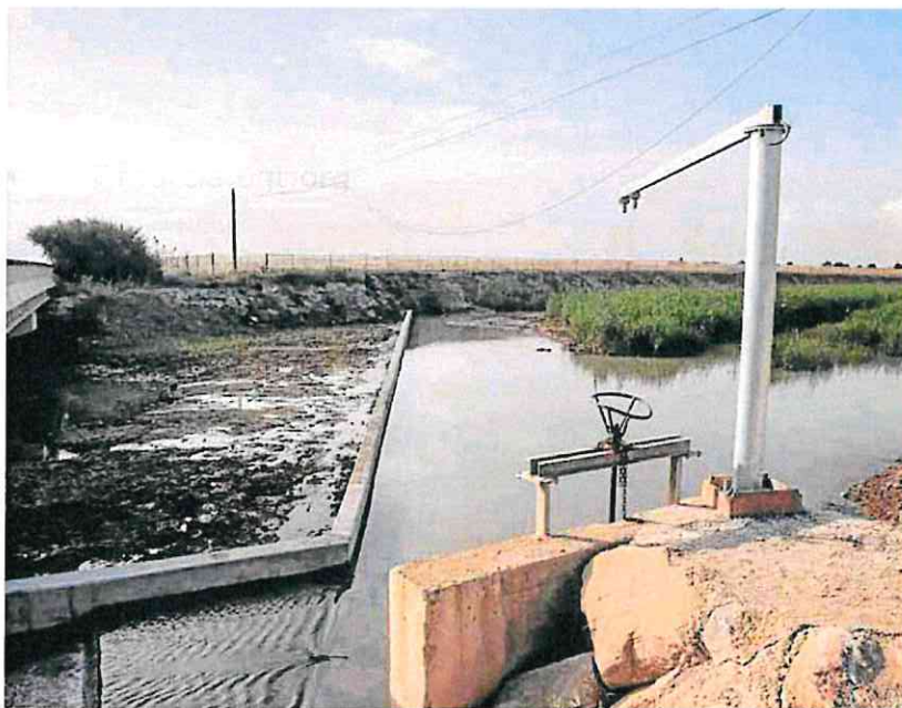
Compuerta que capta el agua de la rambla del Albuñón, ubicada en la desembocadura. J. M. RODRÍGUEZ / AGM
