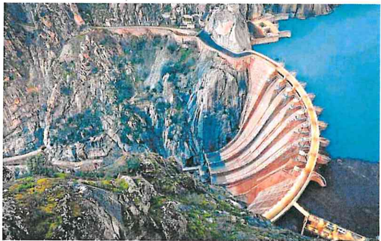
La central hidroeléctrica de Aldeadávila (Salamanca). R. C.
