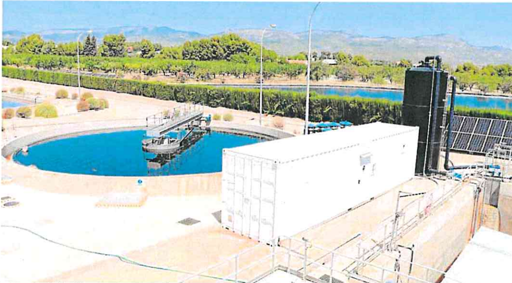
La depuradora de Abanilla, gestionada por Esamur, ha incorporado un tratamiento basado en ozono para eliminar patógenos y contaminantes emergentes. CARM
