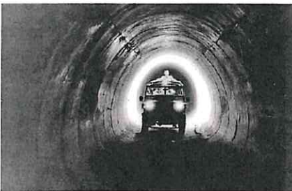
Túnel al Talave
