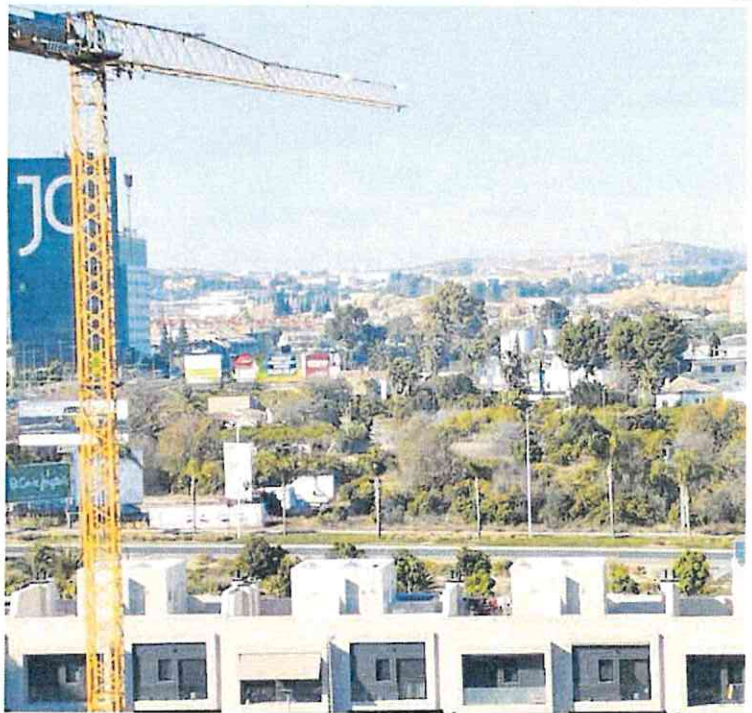
Edificios en obras en la zona norte de Murcia.
