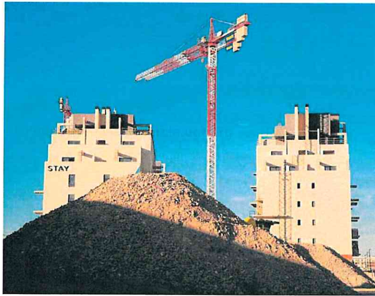
Una promoción de viviendas en construcción. A. LÓPEZ DÍAZ
