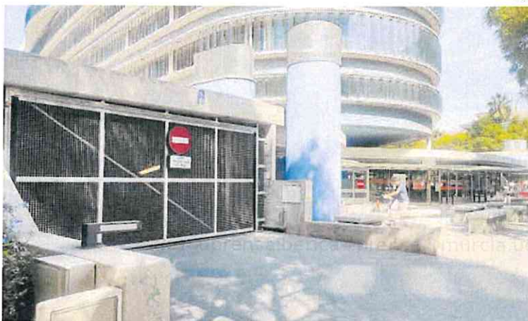
Acceso al aparcamiento subterráneo del Edificio Abenarabi en Murcia.
