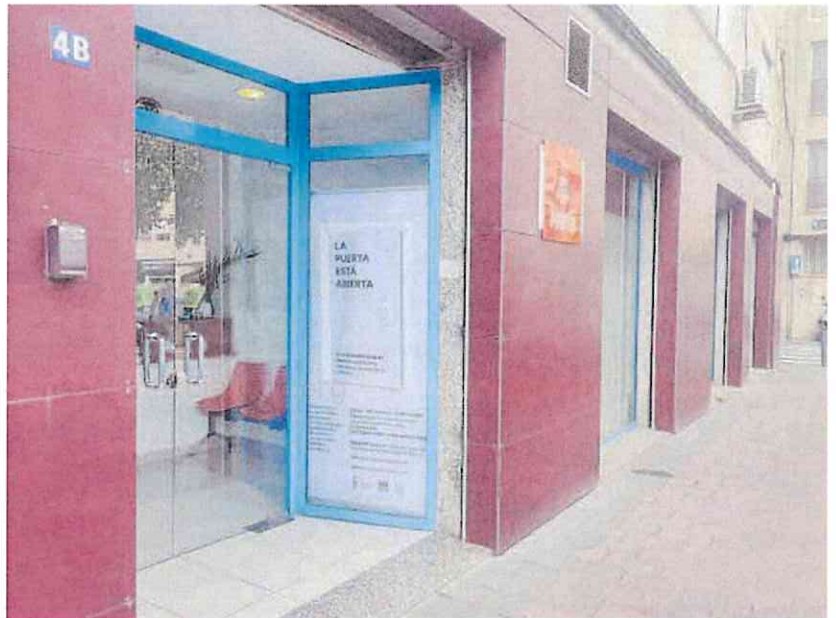
Puerta de entrada a la oficina de atención a la violencia de género, ubicada en el barrio de Vistalegre.
